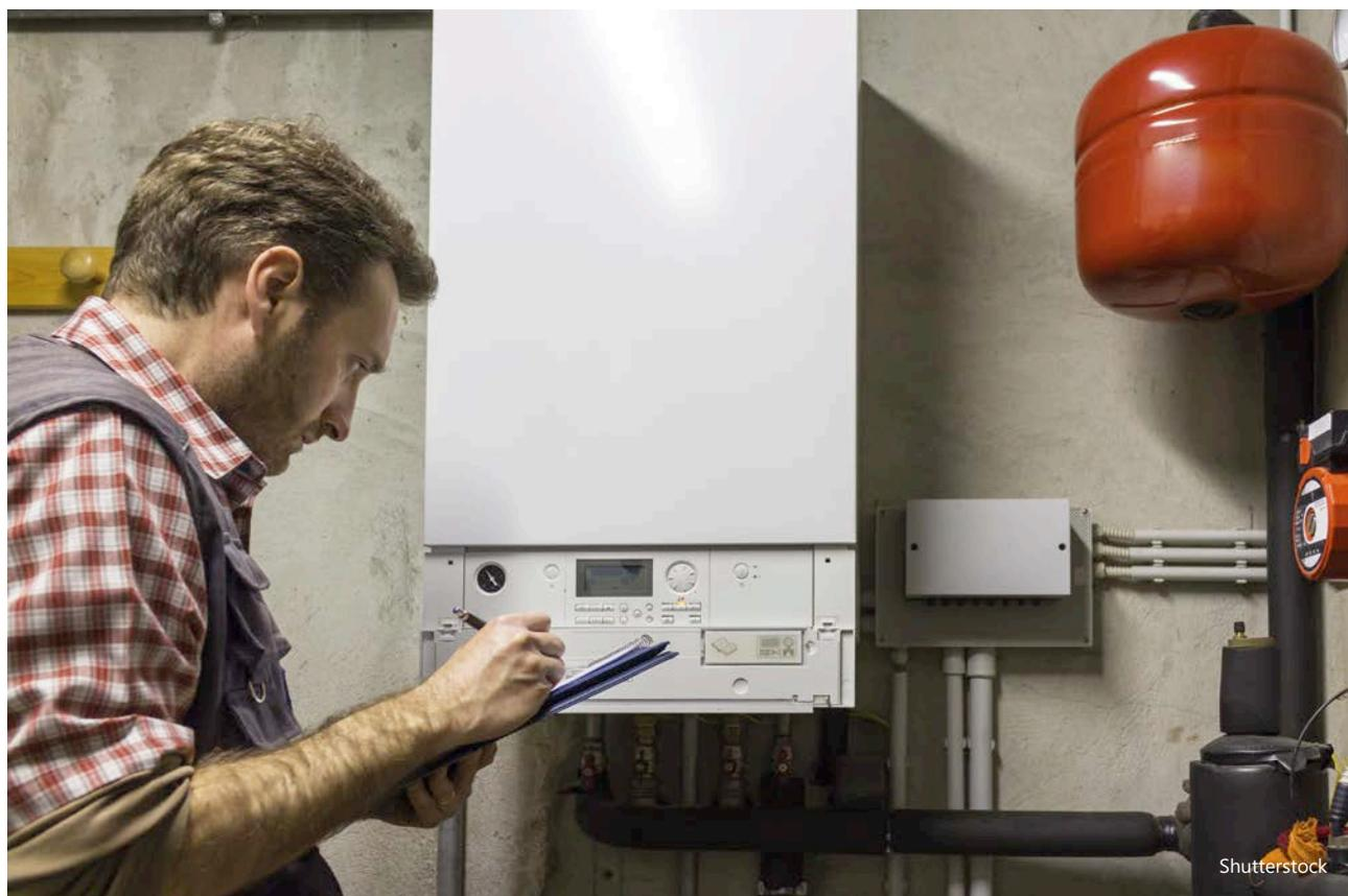
Si le générateur est composé d'**unités distinctes** (un corps de chaudière, un brûleur à air pulsé et une unité de régulation, par exemple), il est possible de ne remplacer que les unités endommagées. Si l'isolant thermique du corps de chaudière a été mouillé et s'est affaissé sous le poids de l'eau, il est à remplacer. Pour un corps de chaudière constitué d'éléments en fonte, il faut en outre contrôler l'étanchéité des joints entre ces éléments.
