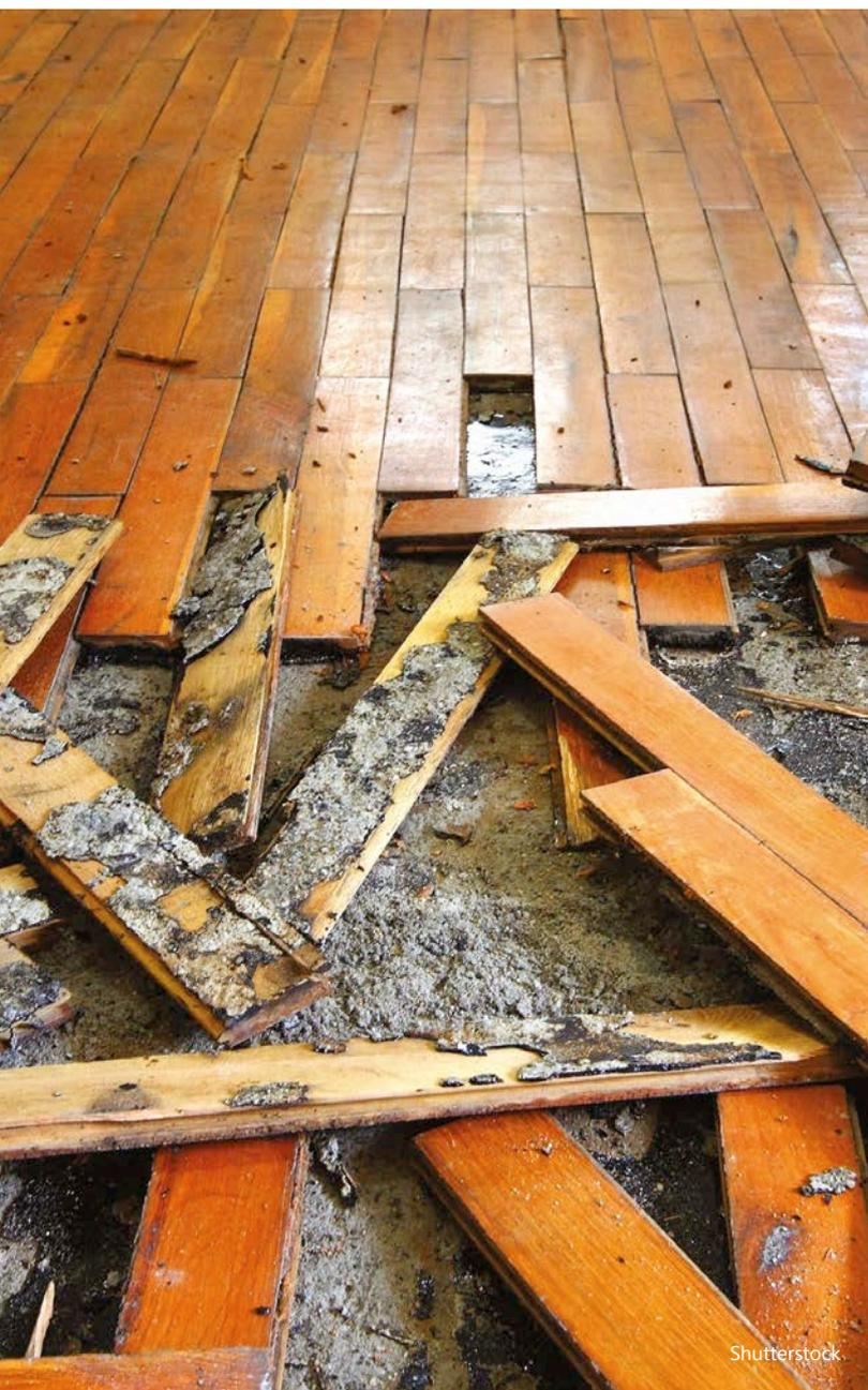
Lorsqu'un revêtement de sol est immergé pendant plusieurs heures, il est courant que des désordres apparaissent rapidement après la phase de nettoyage (tachage, décollement du support, gonflement du matériau, ...). Il est également possible que des dégâts se produisent à plus long terme et ne soient pas directement décelables. La prudence est donc de mise selon la nature du revêtement de sol.
