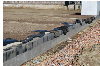
2 | Toepassing van een vloeibare afdichting
