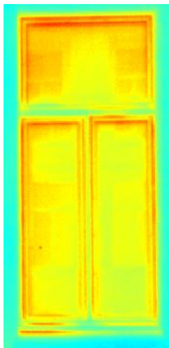
SC 1.1 – maintien du châssis et pose d'un double vitrage
