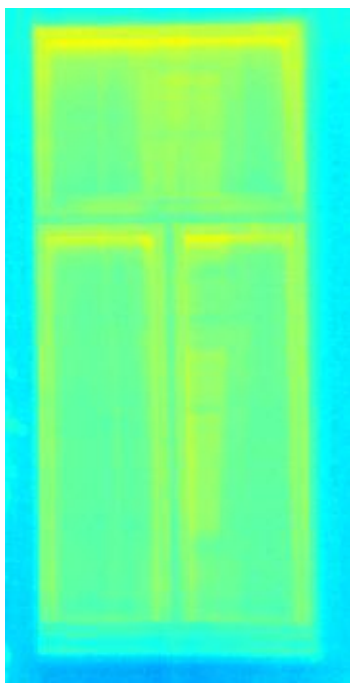
SC 2.1 – remplacement complet de la fenêtre avec un profil gueule de loup
