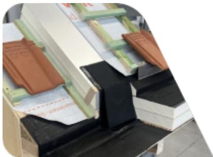
La rénovation du bâti implique en premier lieu l'isolation des toitures, notamment avec la technique **sarking**, dont les détails constructifs sont parfois complexes. En construction neuve, ces détails sont également soumis à de nombreuses exigences (thermique, étanchéité à l'air, ...). Une NIT consacrée aux détails de toiture sarking a été publiée en 2025 et sera alimentée en 2026 avec des fiches complémentaires.
