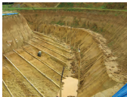
Afb. 2 Uitgraving van de grondankers.
