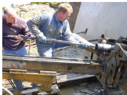
Afb. 1 Installatie van de grondankers.
