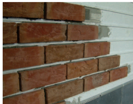
In situ verlijmd steenstrips op de isolatie.
