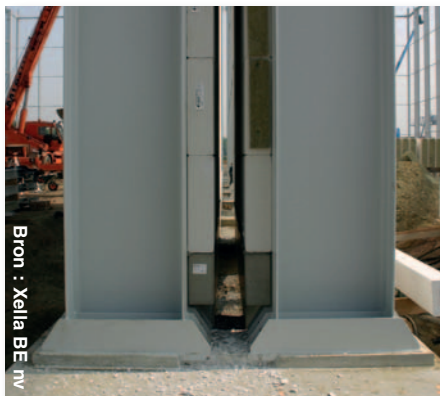
Afb. 2 Dubbele compartimentswand met ontdubbelde draagstructuur.
