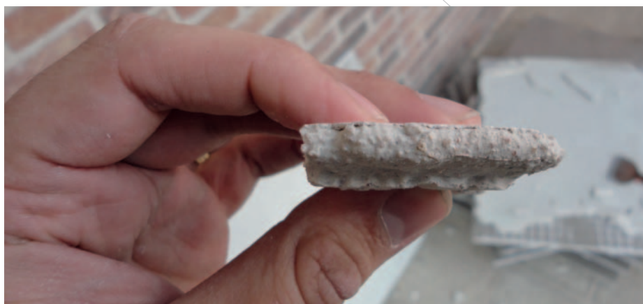
Afb. 1 De bindmiddel huid blijft kleven aan de tegellijm.
