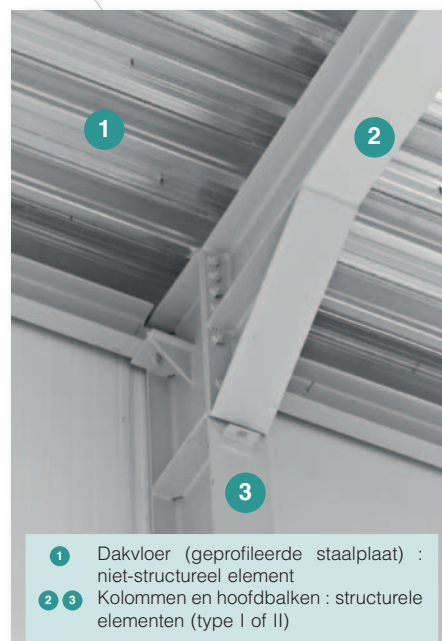
Afb. 1 Voorbeeld van een structureel en een niet-structureel constructie-element.
