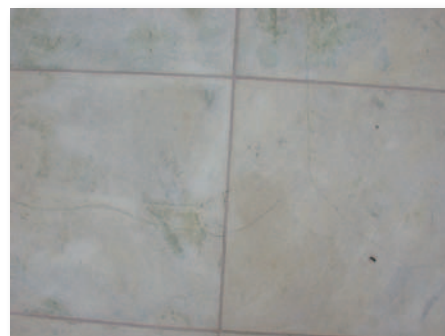
Afb. 1 Scheurvorming in een tegel waarvan het materiaal aangetast werd door vorst-dooicycli.
