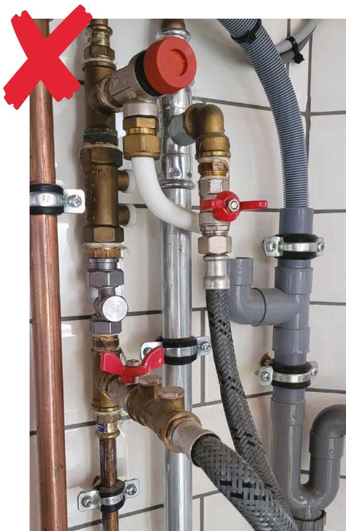
**1** Unsachgemäße Installation: Einbau eines EA-Ventils anstelle eines Rückflussverhinderers vom Typ CA zum Füllen des Heizkreislaufs.
