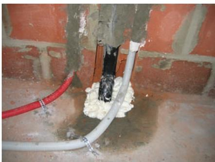
**Fig. 1 Colmatage d'un percement du plancher avant la pose de l'isolation thermique.**
