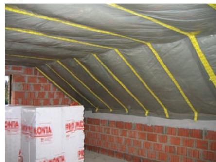
**Fig. 2 Etanchéité à l'air de la toiture réalisée au moyen d'une feuille polyéthylène agrafée à la charpente.**
