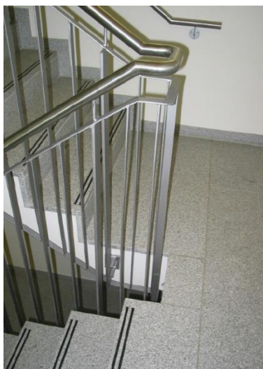
FIGUUR 37: SUBOPTIMALE CONTRASTMARKERING MET BOVENDIEN VERHOOGD RISICO OP VALLEN
