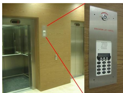
FIGUUR 30: EEN CONSOLE MET ZICHTBARE DRUKKNOPPEN VOOR LIFTEN
