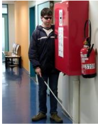
FIGUUR 51: ENKELE SLECHTE VOORBEELDEN: (1) DE RUIMTE ONDER DE TRAP IS NIET AFGESCHERMD (2) DE GLAZEN WAND VAN DE TELEFOONCEL IS ZELFS VOOR PERSONEN MET GEWOON ZICHT MOEILIJK HERKENBAAR (3) DE BRANDHASPEL VORMT EEN OBSTAKEL
