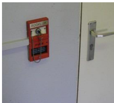
FIGUUR 29: MELDINGSKNOPPEN CONTRASTEREN MET DE WAND
