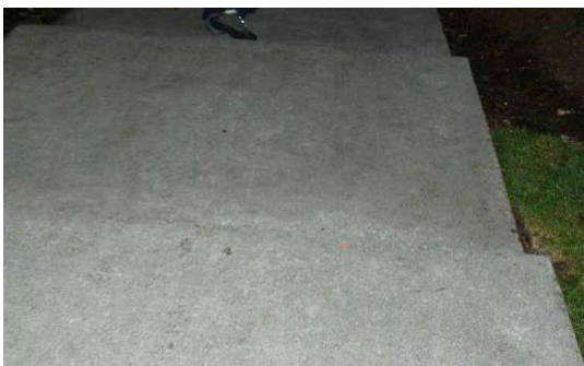
FIGUUR 44: ENKEL RECHTS KAN MEN DOOR DE VERSPRINGING ZIEN DAT ER EEN NIVEAUVerschIL IS
