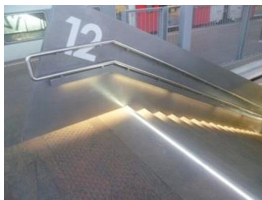
FIGUUR 39: WTCB-DOSSIER 2004/04.06 – TOEGANKELIJKHEID VAN TRAPPEN FIGUUR 40: MET LICHTGEVENDE MARKERINGEN VERKRIJGT MEN HOGERE CONTRASTEN, MAAR OOK MET HET RISICO OP VERBLINDING EN VERMINDERD DIEPTEZICHT
