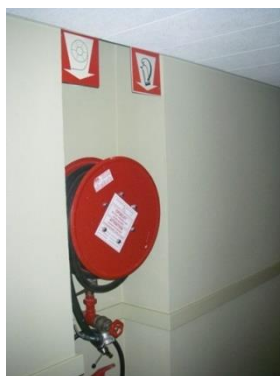
FIGUUR 50: ENKELE GOEDE VOORBEELDEN: (1) DE RUIMTE ONDER DE TRAP KRIJGT OP ORIGINELE MANIER INVULLING (2) PAALTJES CONTRASTEREN MET DE ACHTERGROND (3) BRANDHASPELS WORDEN GEPLAATST IN EEN NIS EN VORMEN GEEN OBSTAKEL
