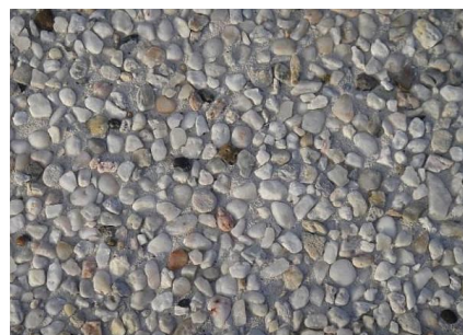
FIGUUR 71: VOORBEELDEN VAN NIET-UNIFORME OPPERVLAKKEN, WAARVAN MEN TOCH DE Y-WAARDE KAN BEPALEN, MITS VOLDOENDE GROTE MEETKOP EN EEN OORDEELKUNDIGE KEUZE VAN DE MEETPUNTEN.
