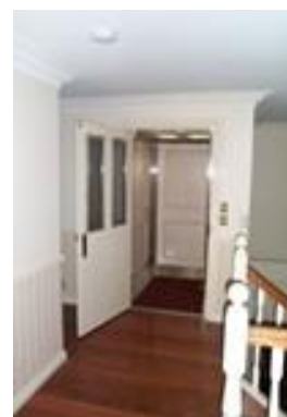
FIGUUR 36: EEN LIFTVLOER IN DEZELFDE KLEUR ALS HET LIFTBORDES EN CONTRASTEREND MET DE WANDEN
