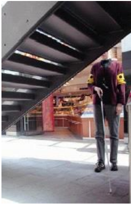
FIGUUR 51: ENKELE SLECHTE VOORBEELDEN: (1) DE RUIMTE ONDER DE TRAP IS NIET AFGESCHERMD (2) DE GLAZEN WAND VAN DE TELEFOONCEL IS ZELFS VOOR PERSONEN MET GEWOON ZICHT MOEILIJK HERKENBAAR (3) DE BRANDHASPEL VORMT EEN OBSTAKEL
