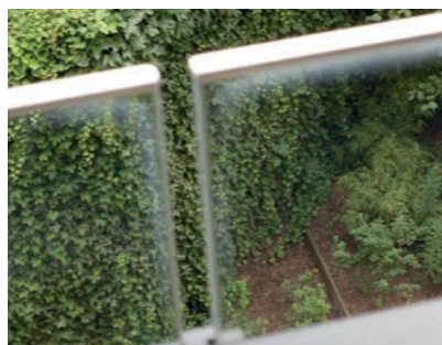
1 | Witachtige verkleuring, te wijten aan het contact met een onverenigbaar lijm (bovenrand) en vocht (zijranden)
