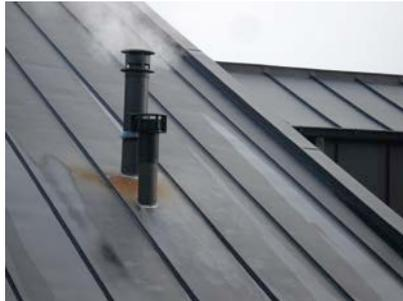
1 | Braune Fleckenbildung auf einem Dach in der Nähe des Rauchgaskanals des Heizungskessels
