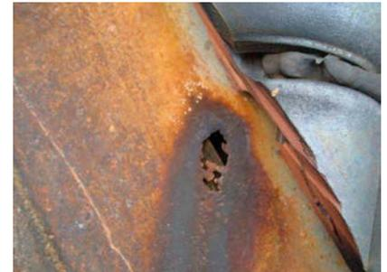
2 | Lokalisierte Korrosion als Folge des direkten Kontakts zwischen Metalldachelementen und den Eisenoxiden
