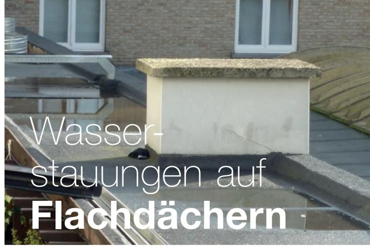
In der TI 215, die 2000 herausgegeben wurde, ist zu lesen, dass infolge von Wasserstauungen noch keine beschleunigte Alterung an synthetischen Membranen oder an Membranen auf Basis von Polymerbitumen festgestellt wurde. Unter bestimmten besonderen Umständen zeigt sich jedoch, dass Schäden in Höhe der Wasserstauungen auftreten können. Diese Feststellung darf aber auf keinen Fall verallgemeinert werden.
