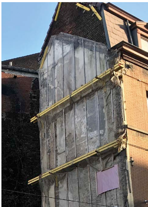
2 Stabilisation d'un mur mitoyen à l'aide de profilés métalliques ancrés dans les façades attenantes.
