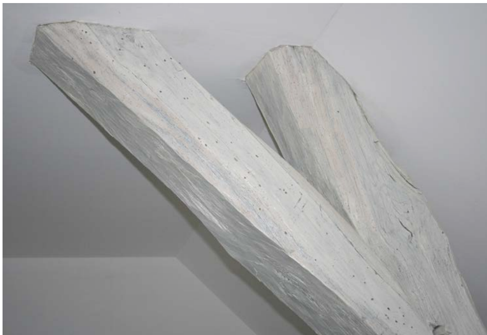
2 Attaque du bois par des insectes.
