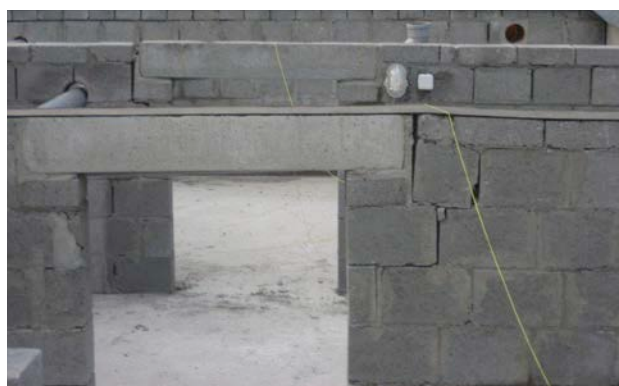
1 Dégâts occasionnés à la maçonnerie portante à la suite d'une période de gel durant la phase de construction.
