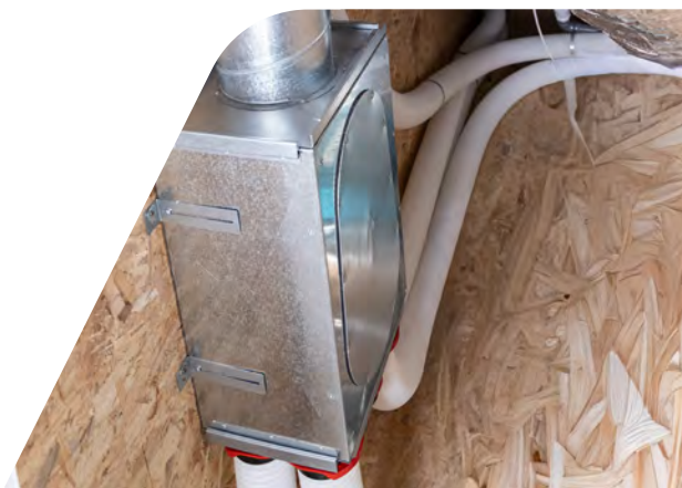
Collecteur avec atténuation acoustique intégrée
