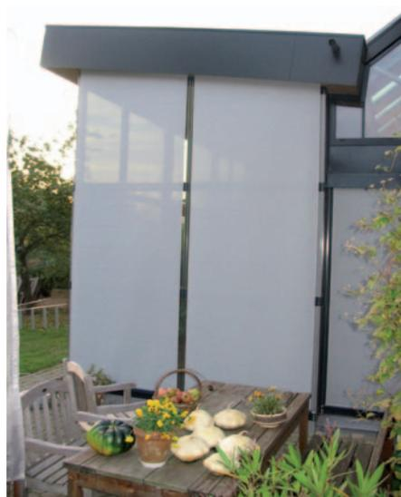
Fig. 3 Protection solaire de type toile extérieure.
