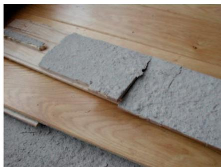
**Arrachement de la partie superficielle de la chape à la suite des mouvements hydriques du bois.**
