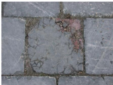
Fig. 1 Pavé fragilisé par métamorphisme et tambourinage.
