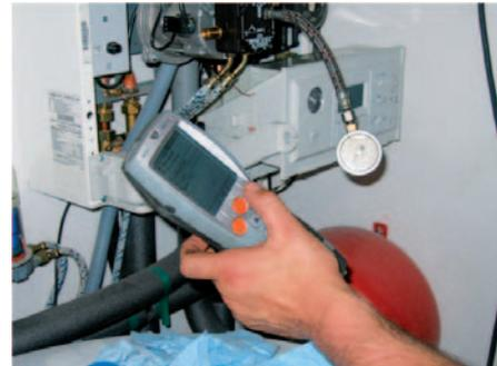
minée peut être effectué par un ramoneur), à régler le brûleur et à contrôler les exigences en matière de combustion et d'émission. Le technicien doit délivrer une attestation au responsable des installations techniques (ou à l'utilisateur de l'installation), ainsi que quelques recommandations éventuelles afin d'améliorer le fonctionnement de la chaudière.
