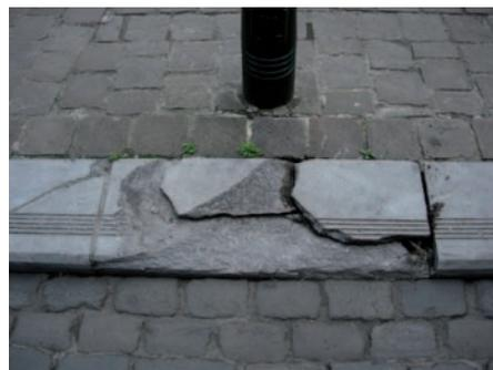
Fig. 2 Bordures calcaires fragilisées et cassées.
