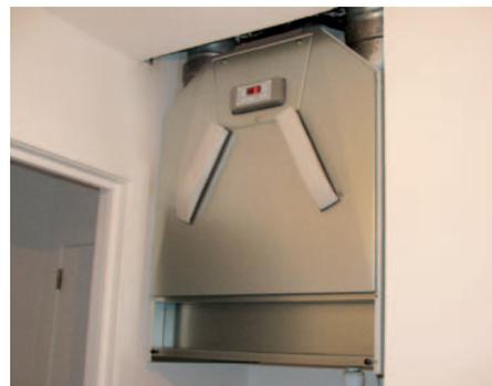
Fig. 2 Ventilateur avec amortisseur de vibrations.
