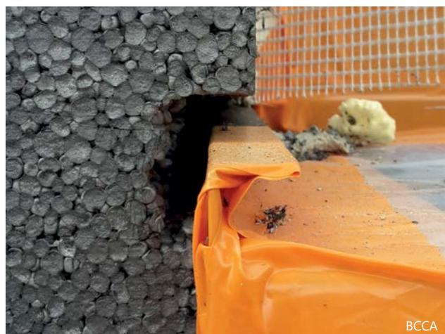
3 | Mangelhafte Anbringung der vorkomprimierten Abdichtungsänder: Nichtvorhandensein eines Bandes am Anschluss zwischen dem Dämmstoff und der Sohlbank sowie falsches Abschneiden des Dämmstoffes.
