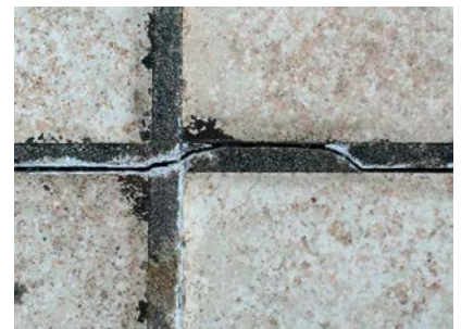
3 | Scheuren door hygrothermische uitzettingen en/of bewegingen van de ondergrond
