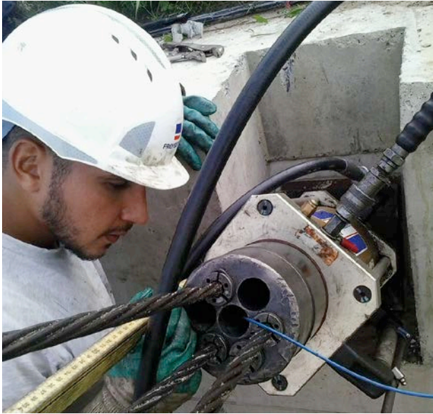
3 | Recuperatie van de meetkabel (blauwe kabel) tijdens de voorspanning van het grondanker
