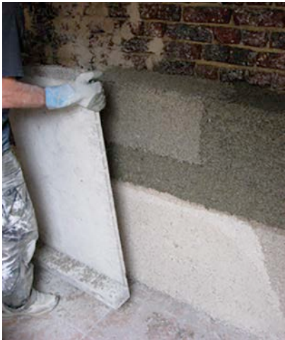
1 | Storten van een bindmiddel-hennepmengsel in een bekisting voor de uitvoering van een voorzetwand
