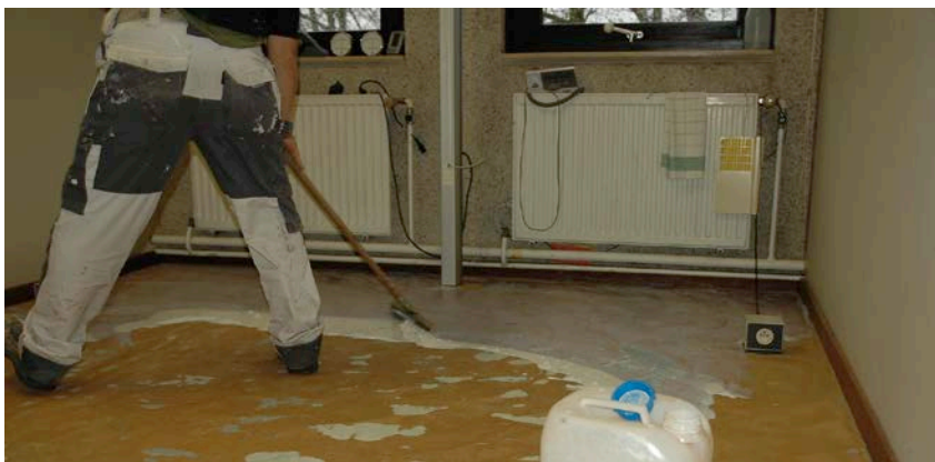
1 | Aanbrengen van een vloeibaar vochtscherm
