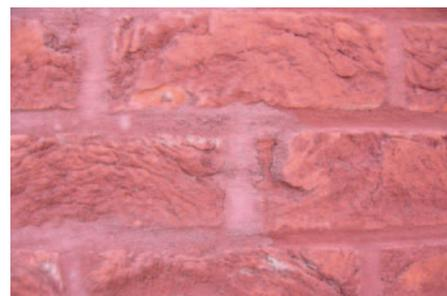
Die **Farbtonvariationen** bei Mörtelfugen können mit Hilfe eines Kolorimeters objektiv beurteilt werden. Hierzu berechnet man für jeden der beiden Bereiche die Abweichungen zwischen den Mittelwerten von sechs Messungen, die gleichmäßig verteilt über die Oberfläche durchgeführt werden. Wenn durch die Farbtonvariationen Ränder entstehen, dann wird ein Gesamt- $\Delta E$ -Wert von 5 Einheiten empfohlen; ohne Ränder sind 10 Einheiten zulässig.
