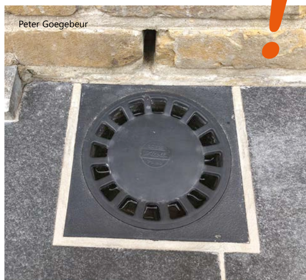
2 | Joint autour d'un avaloir (acceptable si la largeur du joint est constante et si elle n'est pas supérieure ou inférieure de plus de 2 mm à la largeur convenue).
