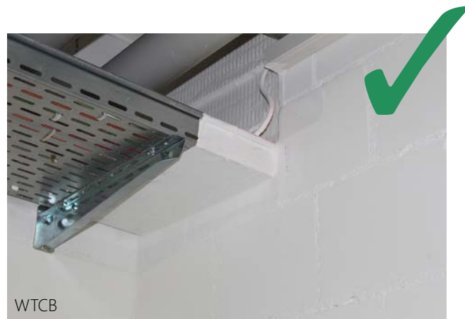
2 | Goede uitvoering van een brandwerende doorvoering van een kabelgoot.
