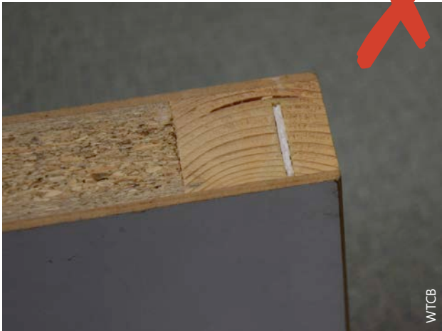
1 | De bovenregel van de deurvleugel en het schuimvormende product werden volledig afgezaagd.
