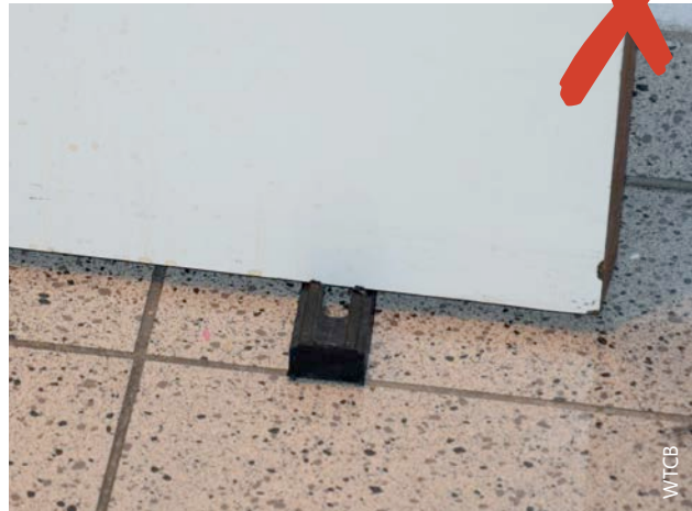
2 | De automatische sluiting van de deur wordt opzettelijk geblokkeerd.
