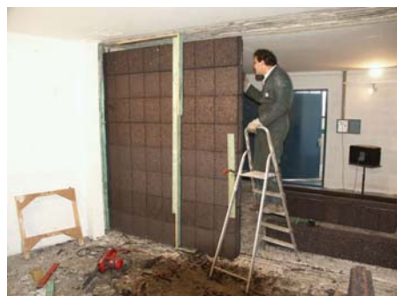
Montage einer Lärmschutzwand im Laboratorium.
