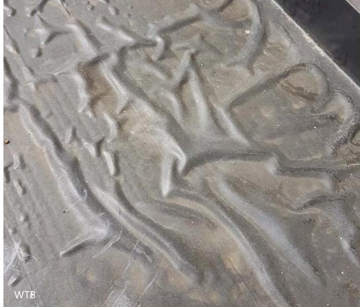
2 | Blasenbildung zwischen der Dämmung und der Abdichtung infolge von eingeschlossenen Lösemitteln.
