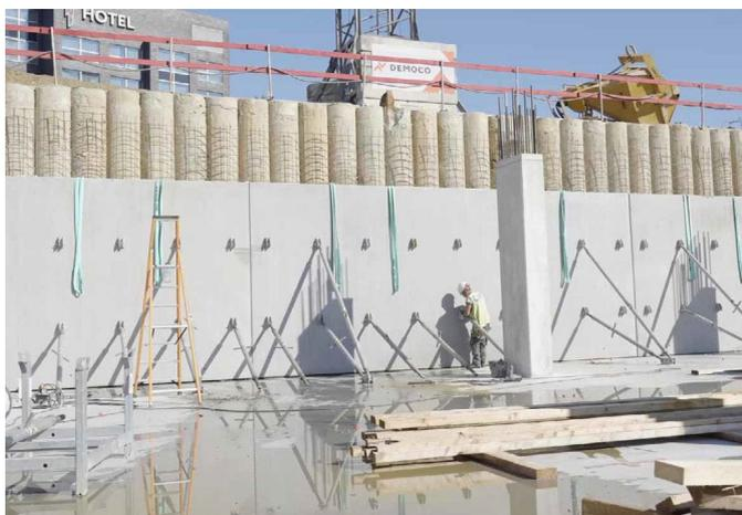
Fig. 1 : Utilisation de modules préfabriqués sur-mesure au lieu de coffrages traditionnels
