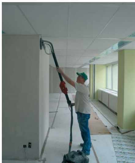
Abb. 2 Manchmal ist es nötig die Oberfläche abzuschleifen.
