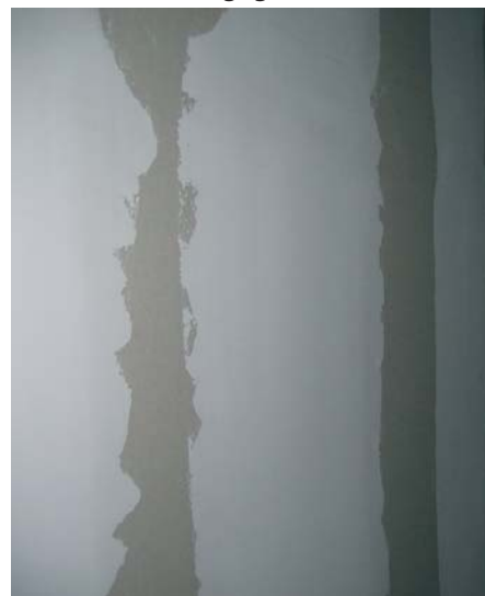
Abb. 1 Durchführen einer Verfugung nach Bearbeitungsgrad Q2.
