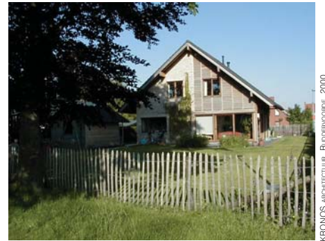
Abb. 2 Energiesparendes Wohnhaus in Holzskelettbauweise.
