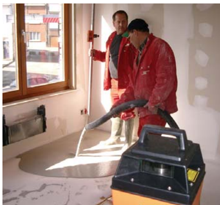
Abb. 1 Anbringen einer Deckschicht auf einem Holzboden.
