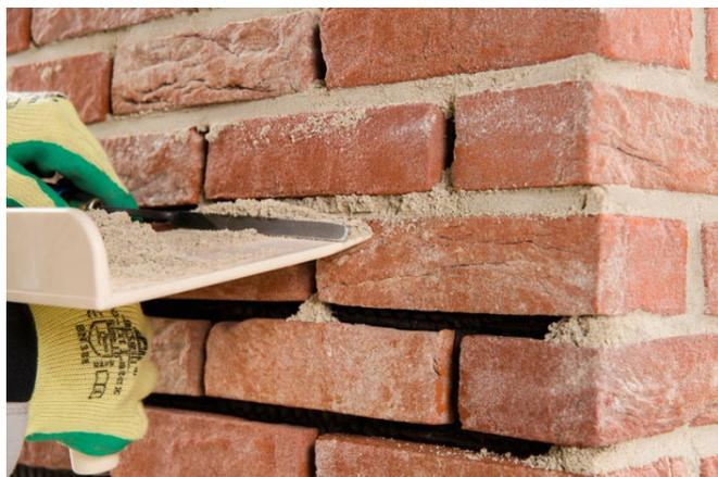
Les travaux de jointoiment des maçonneries sont décrits dans la NIT 208 qui date de 1998 et qui nécessite une révision dans la lignée de l'axe Métier des Ambitions 2025.
