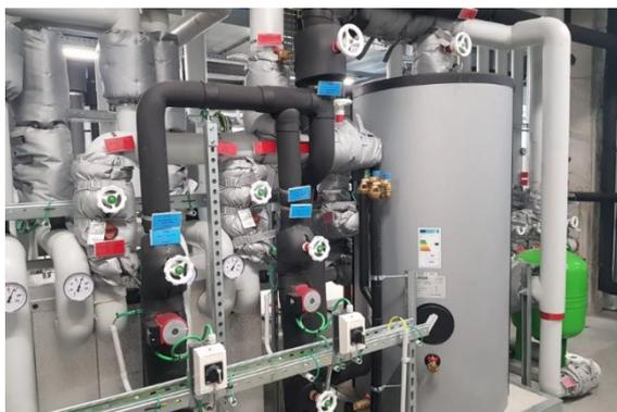
Une installation de chauffage fonctionne souvent en combinaison avec la production d'eau chaude sanitaire.
