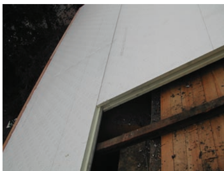
Beispiel eines Sarkingdaches bei Renovierung.
