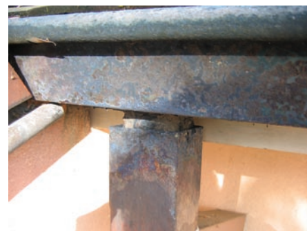
Korrosion in Höhe des Anschlusses zwischen dem Regenwasserabflußrohr und der Dachrinne.
