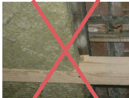
Die Anbringung der Dämmung bei Nichtvorhandensein eines Unterdaches ist nicht empfehlenswert.
