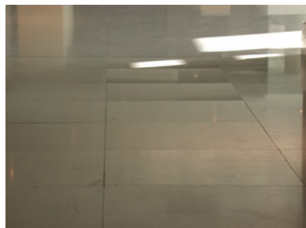
Aussehen eines Bodenbelags mit einer Anzahl von gekrümmten Platten.
