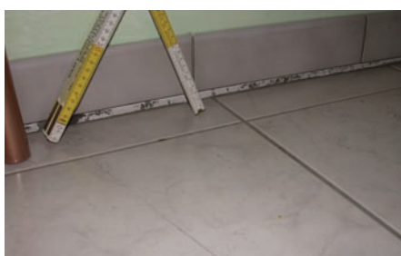
Abb. 2 Absenkung in der Nähe der Sockelleiste.
