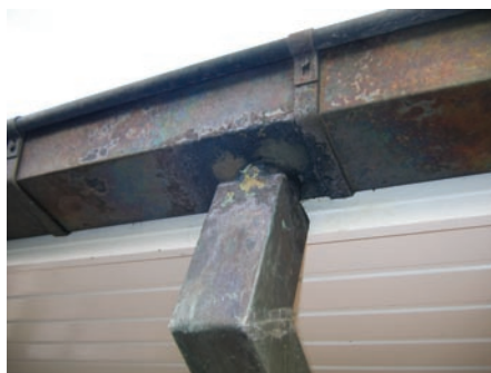
Korrosion in Höhe des Anschlusses zwischen dem Regenwasserabflußrohr und der Dachrinne.
