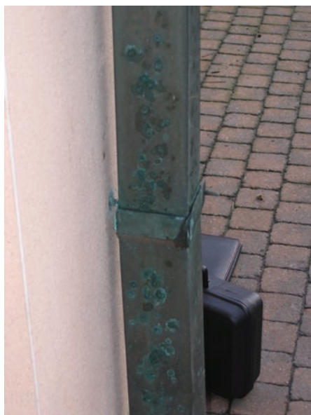
Blaugrüne Färbung eines Regenwasserabflußrohres und seiner Befestigungsschelle.
