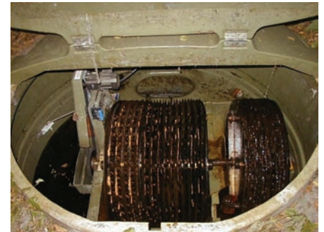
Biorotor voor individuele waterzuivering.
