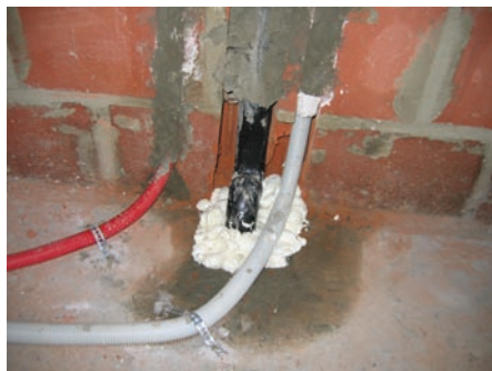
Afb. 1 Afdichting van een doorboring in de vloer, vóór de plaatsing van de thermische isolatie.
