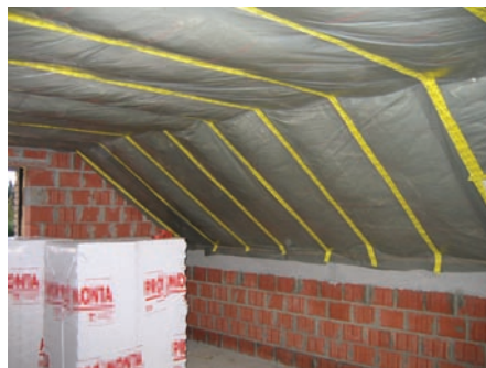
Afb. 2 Luchtdichtheid van het dak, door het vastnieten van een polyethyleenfolie aan het timmerwerk.
