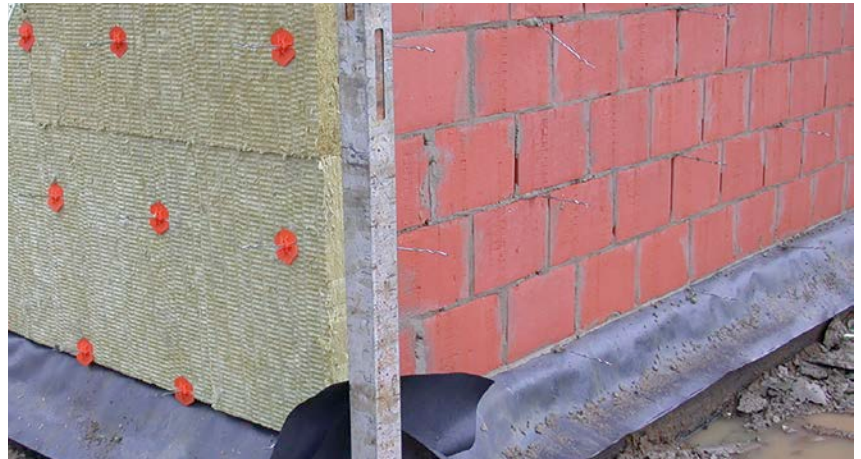
Hohlmaueranker, die in die Mörtelschicht der tragenden Wand eingearbeitet sind
