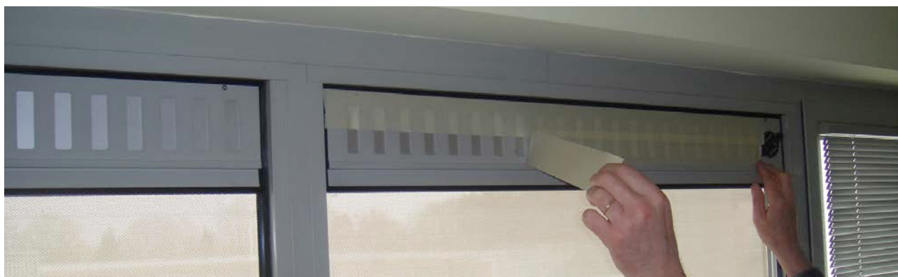
Abdichtung einer Lüftungsöffnung mithilfe eines Klebebands
