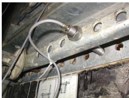
Afb. 2 Plaatsing van een kleine druksensor.
