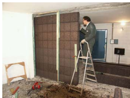
Laboratoriumopstelling van een geluidsscherm.
