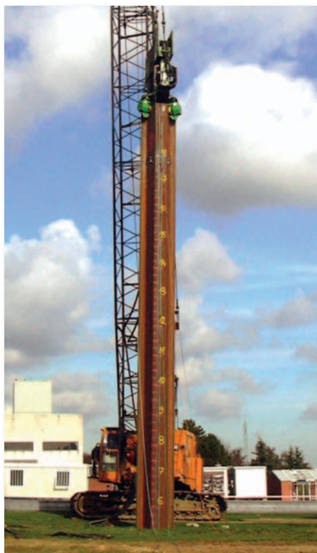
Intrillen van een damplank
