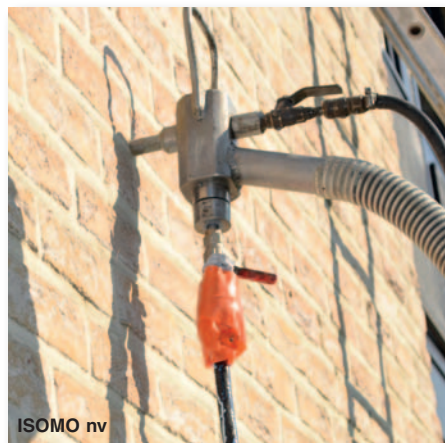
Na-isolatie van een spouwmuur
