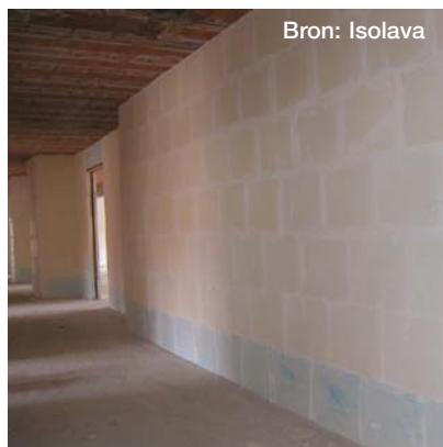
1 | Niet-dragende binnenwand uit gipsblokken
