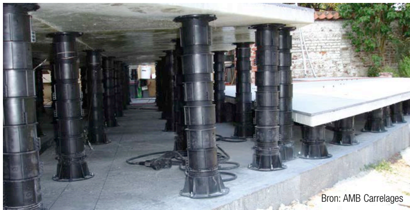
1 | Voorbeeld van een vloersysteem op tegeldragers
