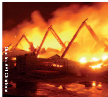
Abb. 3 Einsturz der Fassaden nach innen.
