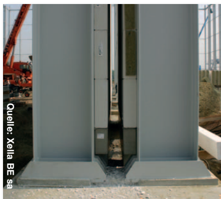
Abb. 2 Verdoppelte Abteilungswand mit doppeltem Stahltragwerk.
