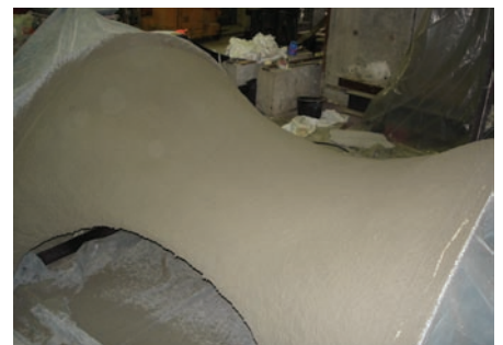
Afb. 3 Uitvoering van een dubbelgekromde schaalstructuur met spuitbeton.
