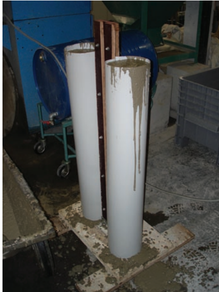
Afb. 1 Uitvoering van rechte ronde kolommen met een textielbekisting.
