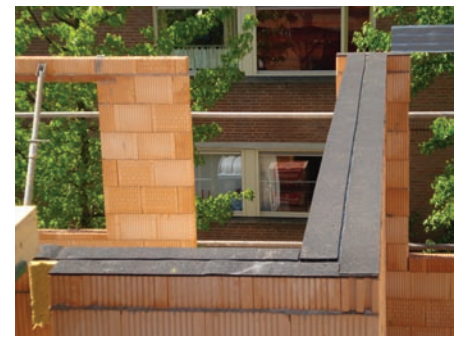
Fig. 2 Les bandes en matériau résilient (en noir sur la photo) assurent une coupure acoustique entre les dalles de béton et le reste de la structure.
