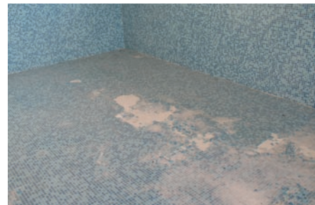
Décollement de carrelats au fond d'une piscine.
