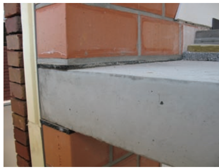
Fig. 2 Les bandes en matériau résilient (en noir sur la photo) assurent une coupure acoustique entre les dalles de béton et le reste de la structure.
