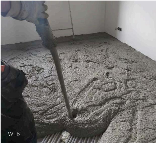
2 | Ausführung einer Ausgleichsschicht aus EPS-Mörtel.
