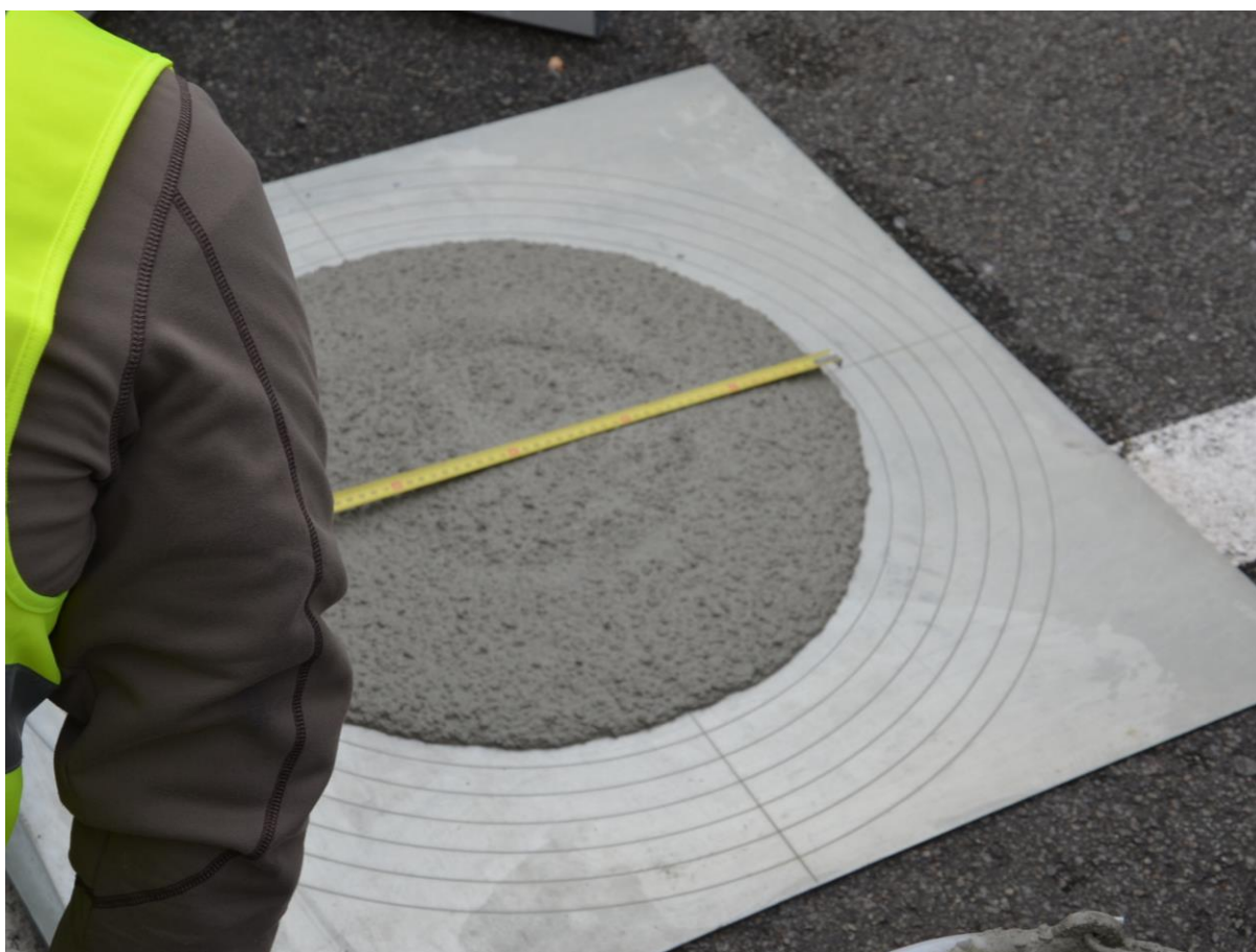
Figuur 3: Meting van de vloeimaat (slump-flow)
