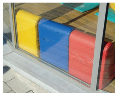
Fig. 2 Exemple de casse thermique sous l'influence de l'environnement interne
