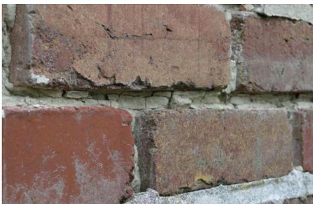
**3** Erhebliche Frostschäden am Mauermörtel.
