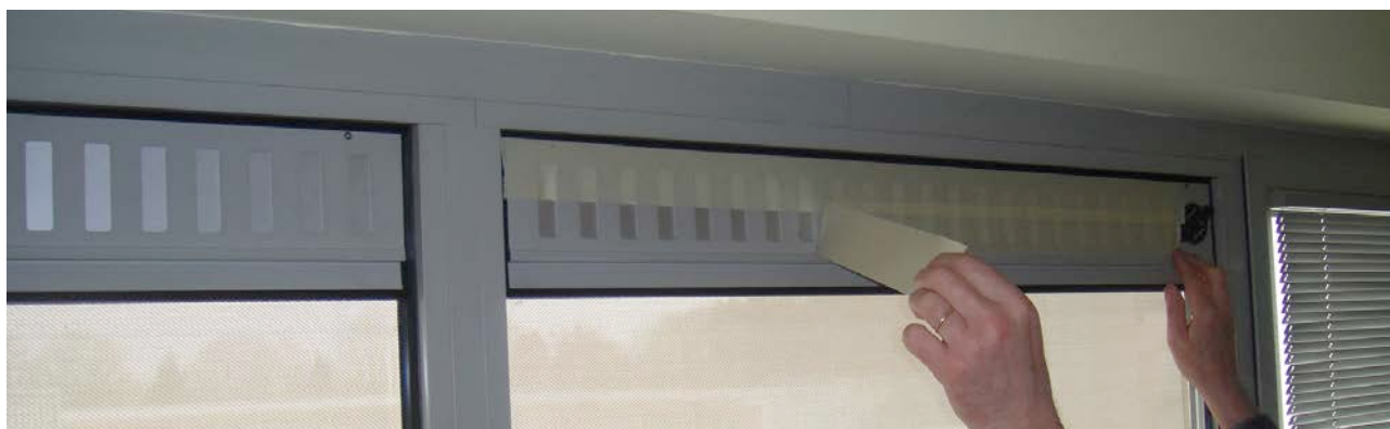
Afdichting van een ventilatieopening door middel van een kleefband
