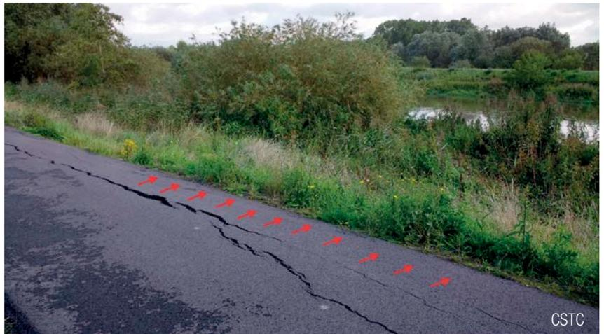
1 | Fissures observées en tête d'une digue instable située le long de l'Escaut, à Melle.
