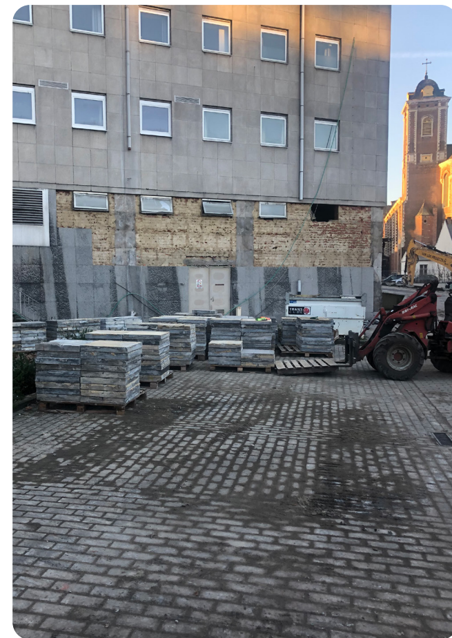
Ontmantelen van natuurstenen buitenafwerking. © Stad Mechelen
