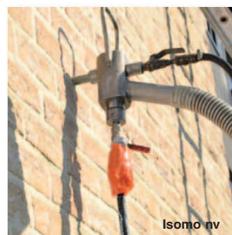
Nachträgliche Wärmedämmung einer Hohlwand.
