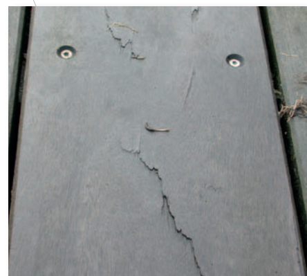
Abb. 2 Aufspalten der Holzoberfläche.
