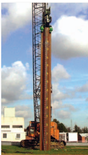
Anbringung einer Spundbohle durch Vibrationsrammen.
