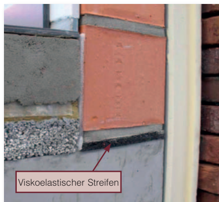
Im Bereich der Verbindungsstelle Boden/Wand zur Verringerung der seitlichen Übertragungen eingesetzt viskoelastischer Streifen .
