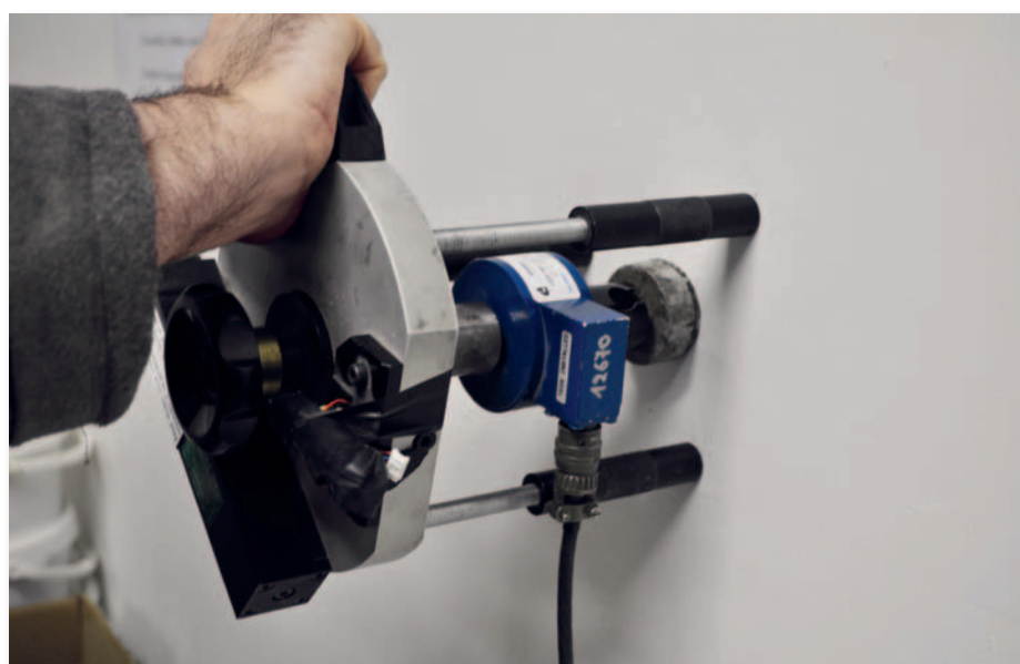
Abb. 4 Abreißprüfung nach der Norm NBN EN 1504-2.
