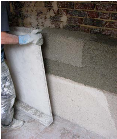
1 | Gießen einer Bindemittel-Hanf Mischung in eine Schalung für die Ausführung einer Vorsatzwand
