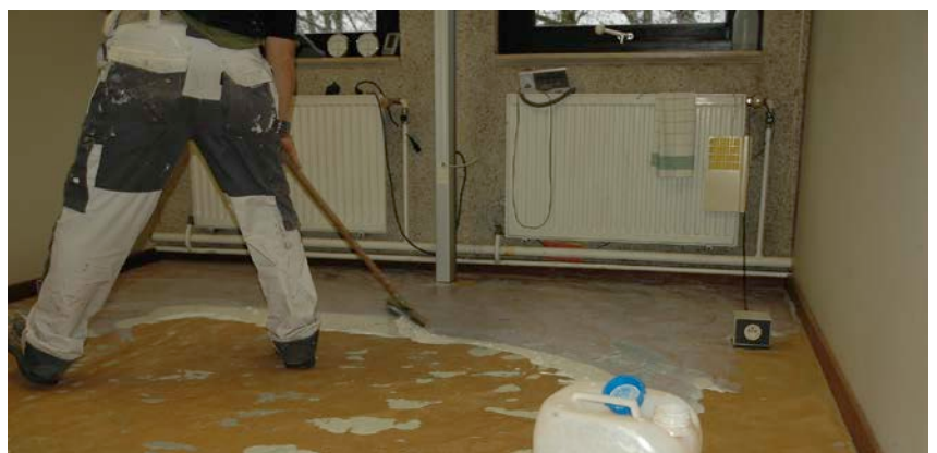
1 | Anbringen einer flüssigen Feuchtigkeitssperre
