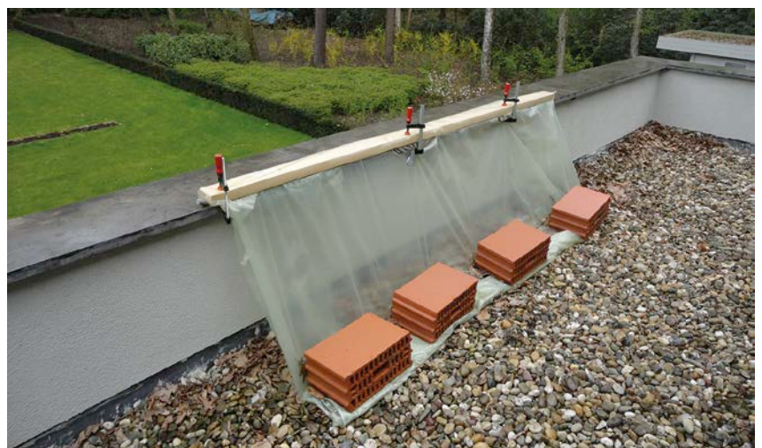
1 | Der vorübergehende Schutz eines Teils der Attika vor Schlagregen
