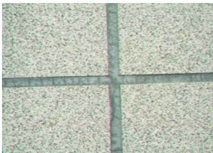
1 und 2 | Schwindungsrisse in der Fuge eines Plattenbelags und eines Mauerwerks
