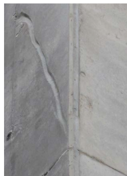
4 | Empreinte à la surface du béton dû au plissement de la nappe de coffrage
