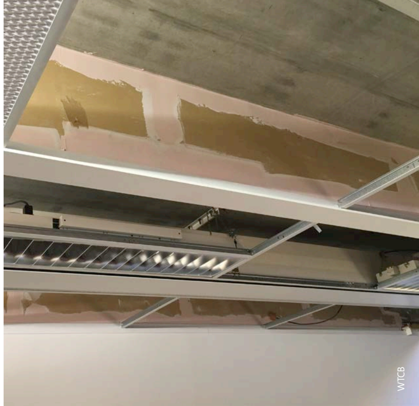
2 | Vaste branddammen die met een regelmatige tussenafstand in het plenum van een verlaagd plafond aangebracht worden.
