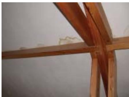
**Écoulement d'eau résultant d'une condensation sur la face inférieure d'une sous-toiture souple en PE microperforé : l'étanchéité à l'air des raccords entre les plaques de plâtre enrobé de carton et la ferme est très difficile à réaliser.**
