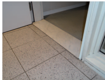
Afb. 2 Plaatsing van een stenen deurdorpel
