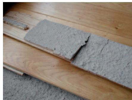
Loskoming van het bovenste gedeelte van de dekvloer tengevolge van de hygrische bewegingen van het hout.
