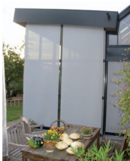
Afb. 3 Zonnewering bestaande uit een doek die aan de buitenzijde bevestigd wordt.
