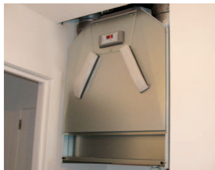
Afb. 2 Trillingsgedempte wandmontage van een ventilatorunit.
