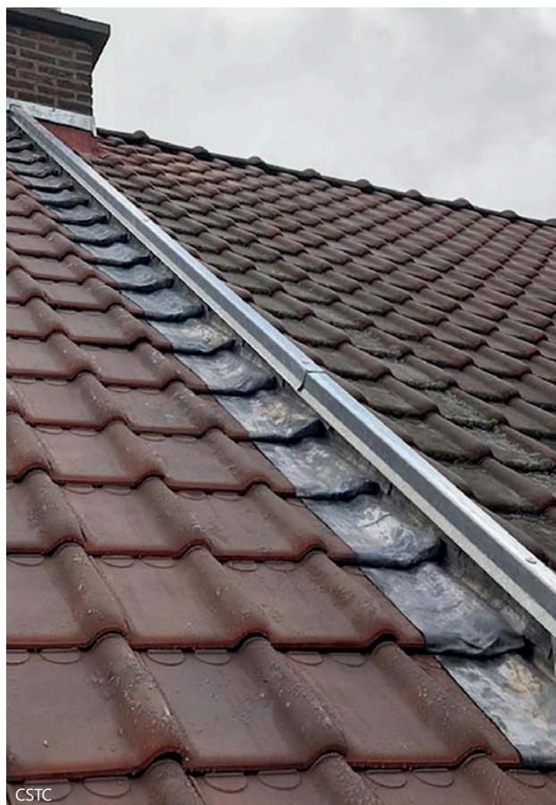
3 | Jonction entre une toiture rénovée (à gauche) et une toiture existante (à droite) à l'aide d'un tasseau.
