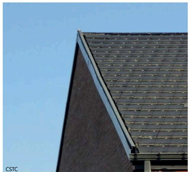
2 | Finition des rives de toiture à l'aide d'un profilé spécifique.
